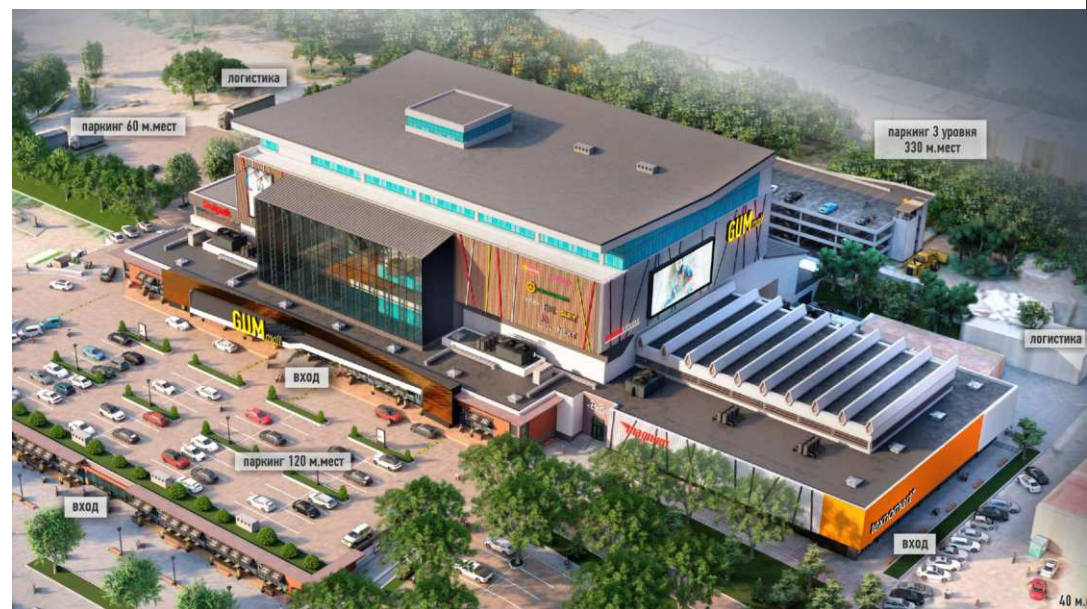
ВИД ПОСЛЕ РЕКОНСТРУКЦИИ "GUM MALL»
